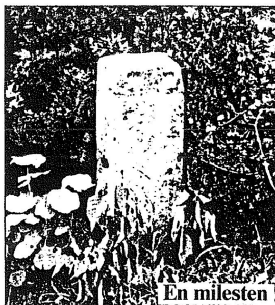
Fig. 1. Halvmilestenen er af granit, cirka 70 cm høj. Forneden cirka 25x25 cm, foroven lidt smallere. Den er solidt forankret, idet den er hugget ud i eet med fundamentet.
